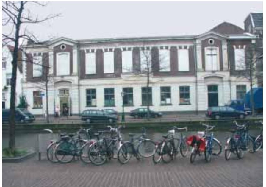
Van de oude Aalmarktschool wordt de gevel later opnieuw opgebouwd
